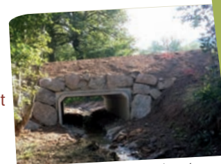
Pont cadre installé sur le Chandonnet
