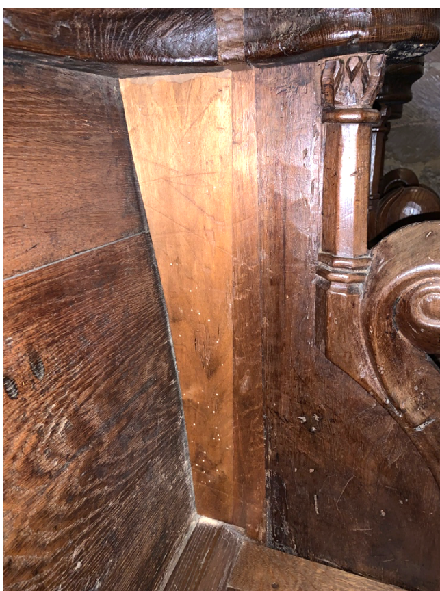
Groupe Nord : présence de trous d'envol récents sur les greffes en noyer des parcloses
