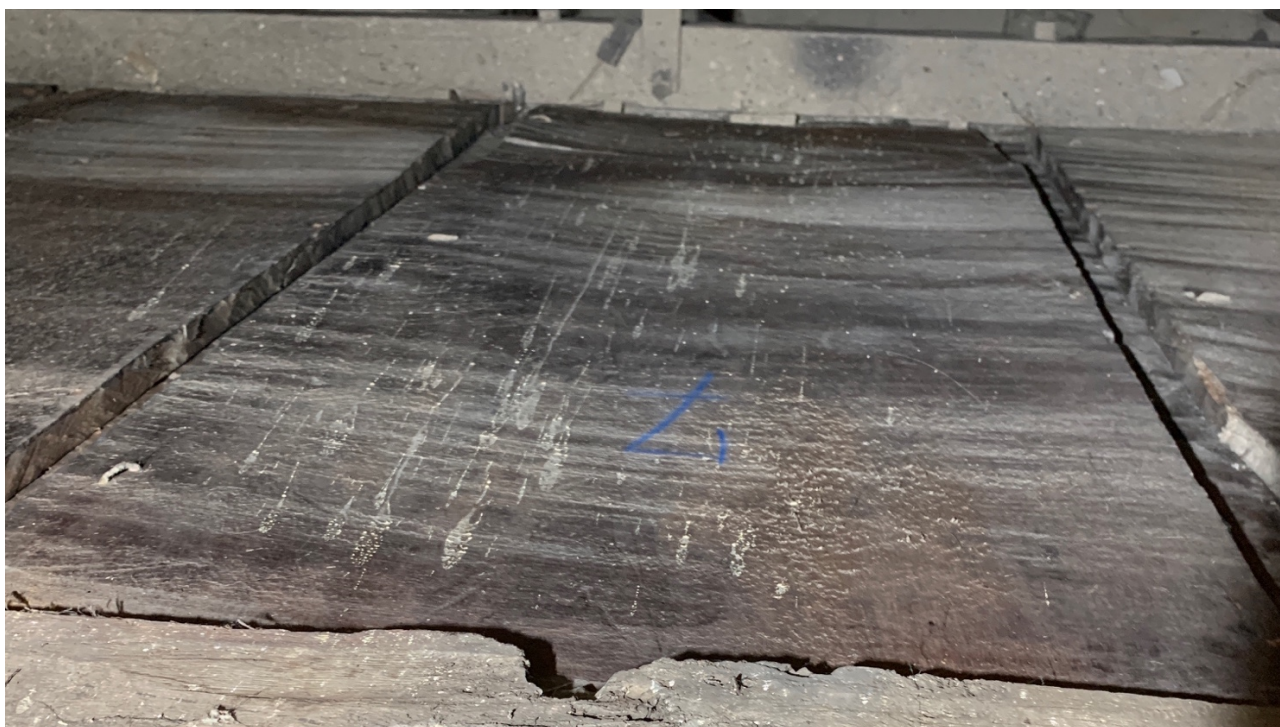
Groupe Sud : Traces de sciage au revers des panneaux
