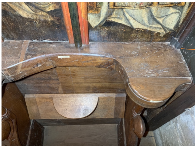
Groupe Nord, extrémité Est : élargissement de la stalle et greffes
