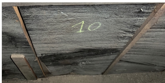
Groupe Nord : Numérotation au revers des panneaux à la craie jaune
