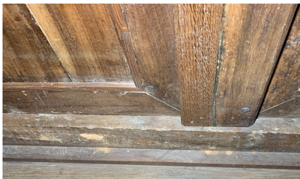
Groupe Sud : sciure issue de trous d'envol à la base des pupitres
