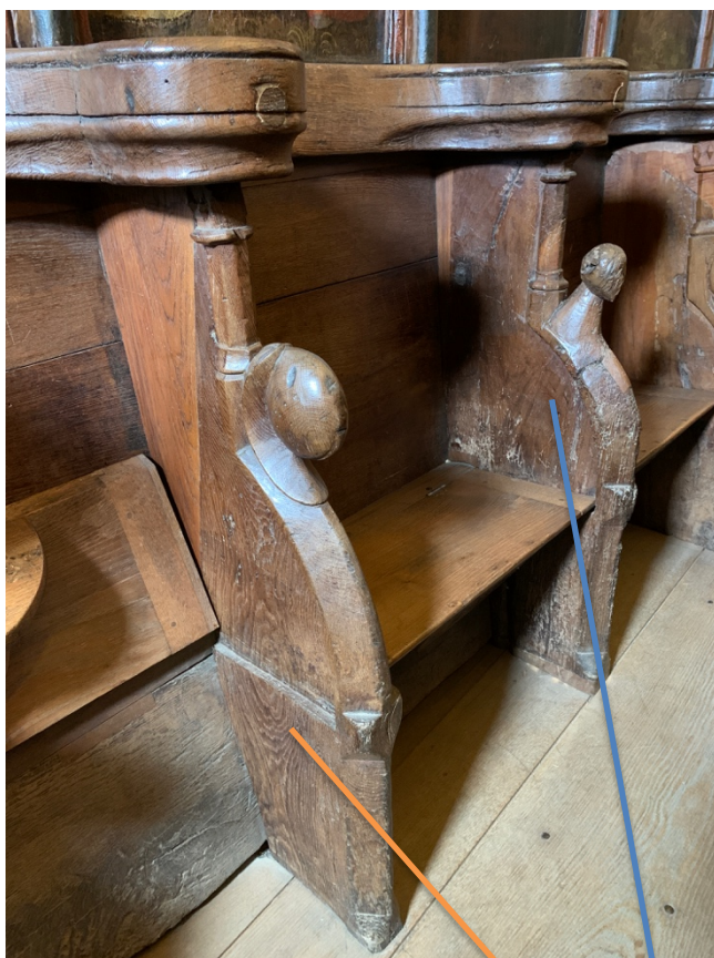
Groupe Nord : Les parcloses sont réalisées en chêne ou en noyer
