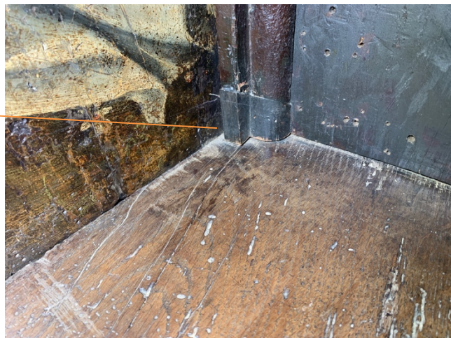
Groupe Nord, extrémité Est : Greffe à la base d'un montant
