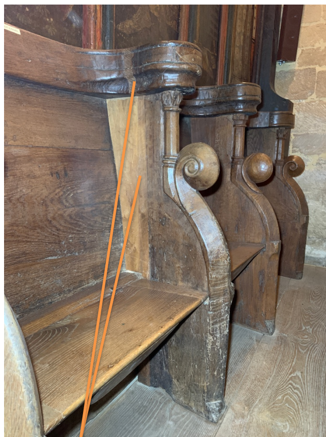
Groupe Nord : Greffe en partie arrière de la parcloses et sur le chant d'un museau
